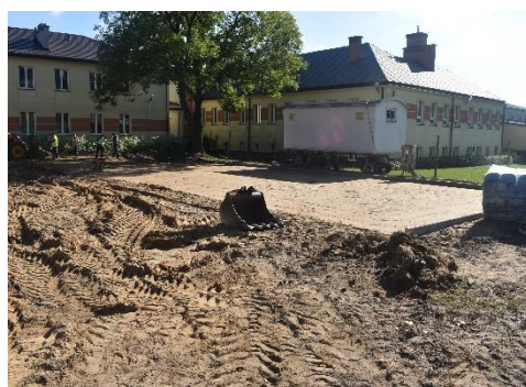
W TRAKCIE BUDOWY
