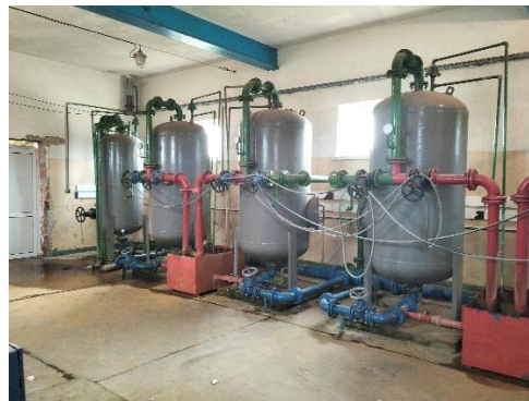
W trakcie raealizacji
