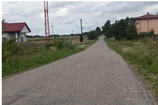
Przed modernizacją FLORENCJA – ADAMOWO
