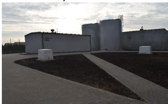
Po zakończeniu inwestycji
