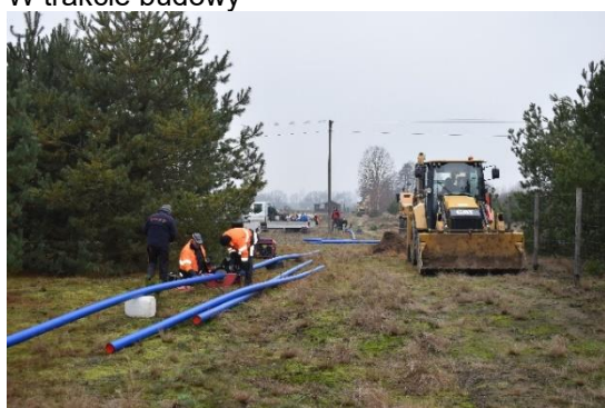
W trakcie budowy
