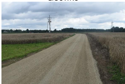
W trakcie realizacji MOCHOWO-PARCELE – ŻURAWIN
