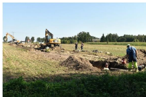
W trakcie budowy
