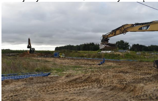
W trakcie budowy
