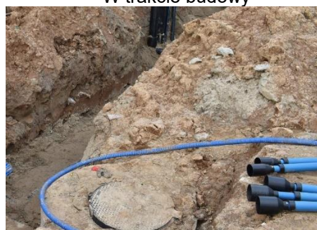
W trakcie budowy
