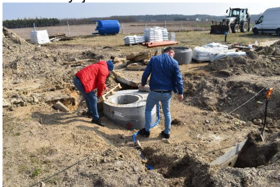
W trakcie realizacji
