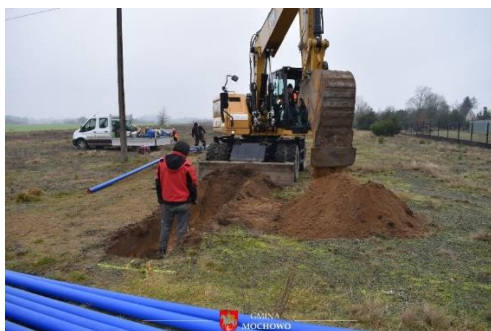
W trakcie budowy
